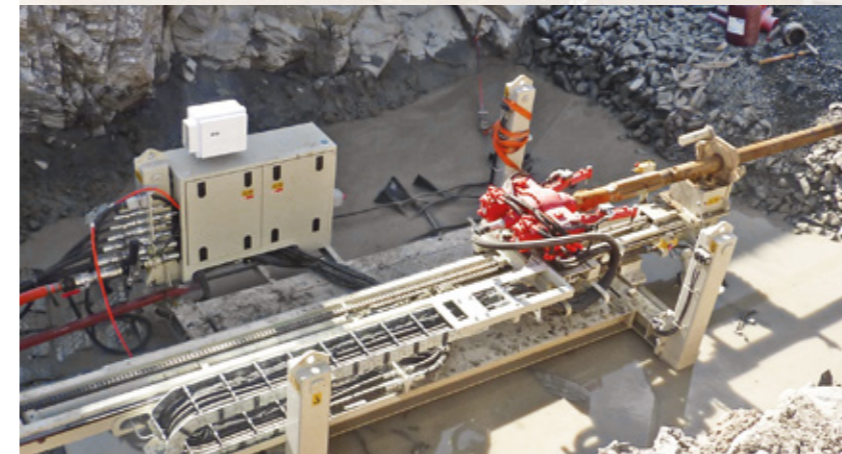
Perforatrice speciale su skid per perforazioni orizzontali Special skid mounted drill rig for horizontal drilling
