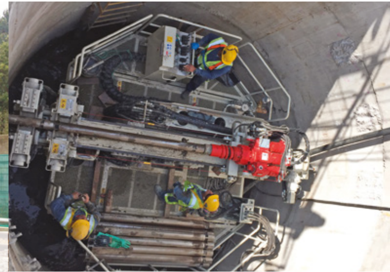
Perforatrice speciale MC-S 12 su piattaforma progettata per l'esecuzione di compensation grouting all'interno di pozzi Special unit MC-S 12 designed to perform compensation grouting inside shafts.
